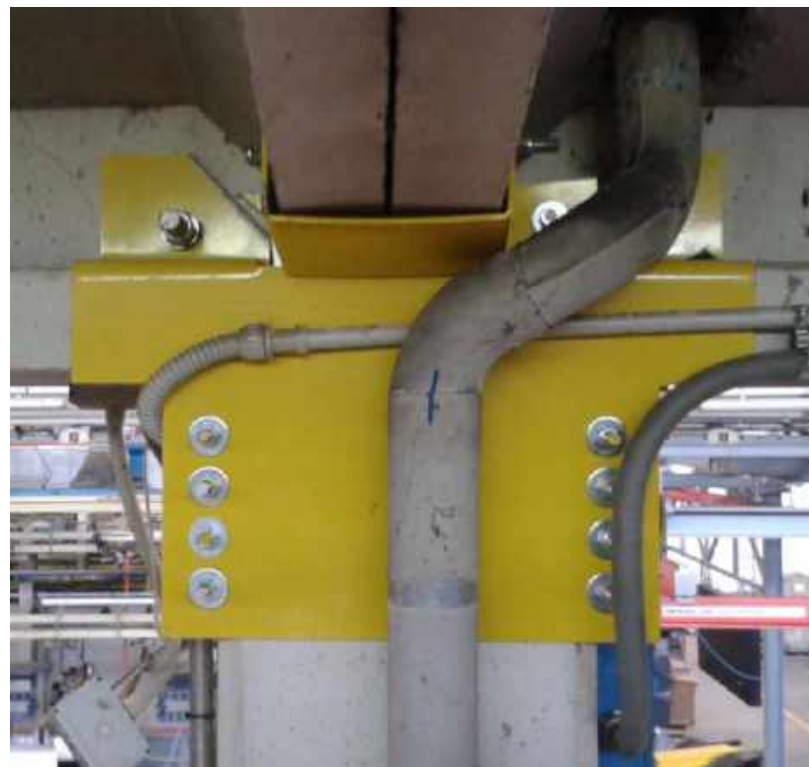
Collegamento pilastro-trave-tegolo
