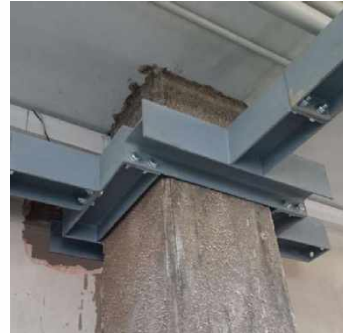
Collegamenti pilastri con setti esterni
