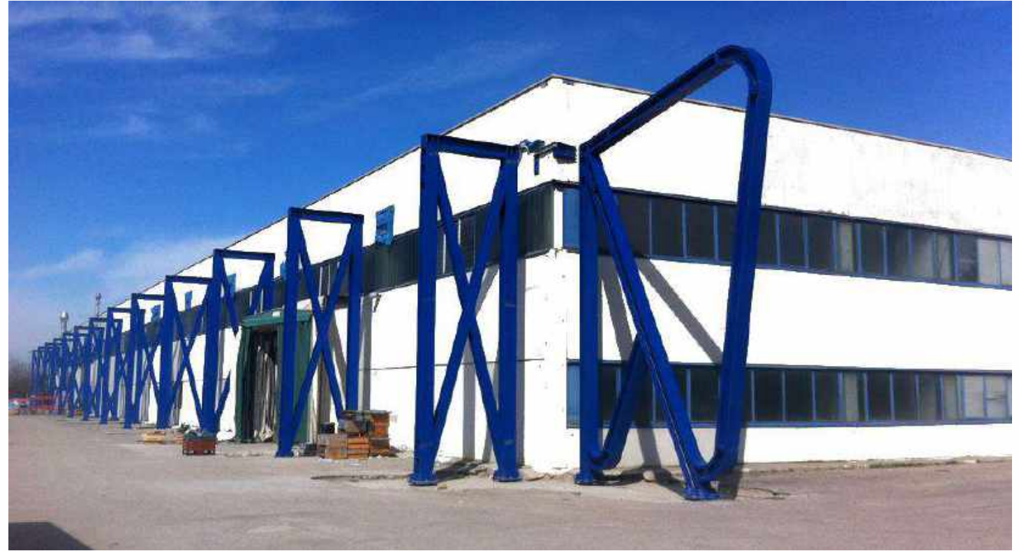
Realizzazione ultima del miglioramento sismico
