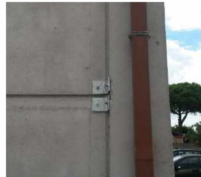
Collegamento pilastro-pannello
