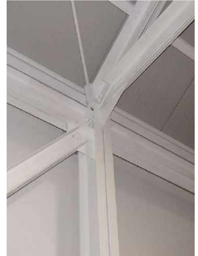
Nodo di collegamento
