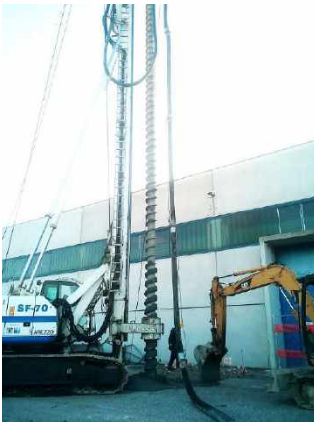
Trivellazione pali
